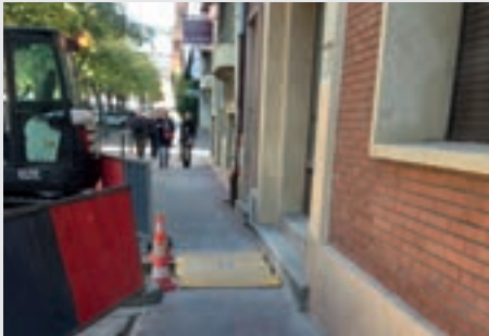
Pont piéton en plastique - Toulouse Métropole
