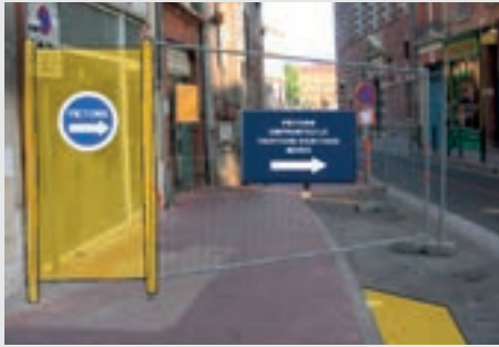
Travaux sur trottoir sans itinéraire accessible - Toulouse
